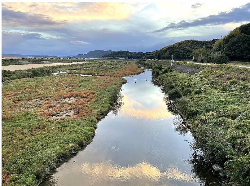
小田川 (真備町箭田・箭田橋より 福松橋方面を望む)
